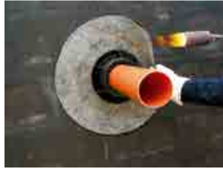
5. Bitümü ısıtarak yapıştırın
